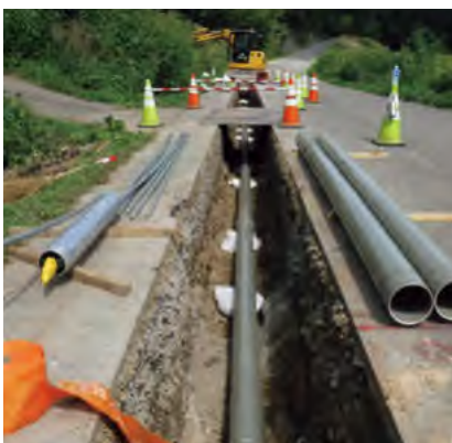
管路布設工事
