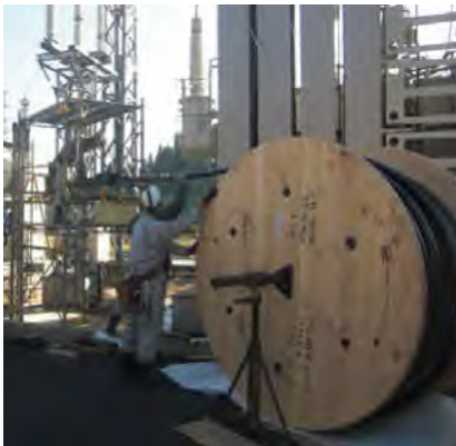
ケーブル引替工事
