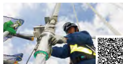
長大吊橋ロープ補修のページへ
