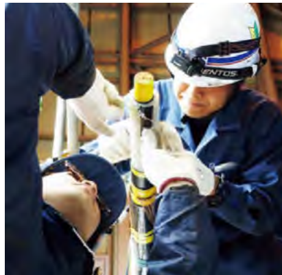
ケーブル接続作業
