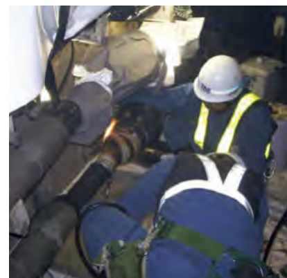
OFケーブル漏油補修
