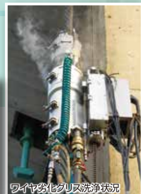
ワイヤ劣化グリス洗浄状況
