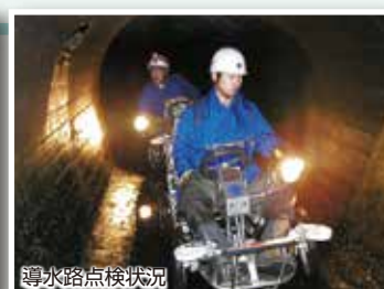
導水路点検状況
