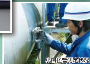
水管橋測定状況
