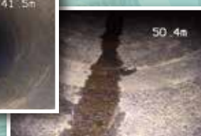
鋼管内部点検映像
