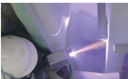
Arts工法（防錆溶射）
