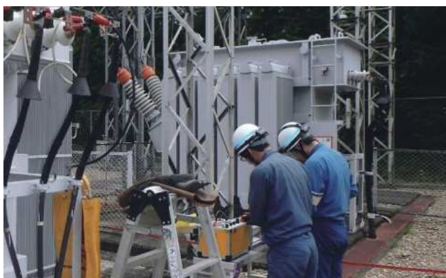
直流漏れ電流法
