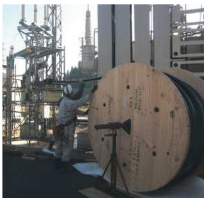
ケーブル引替工事
