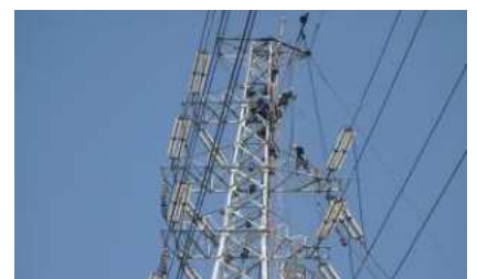
劣化鋼材取替
