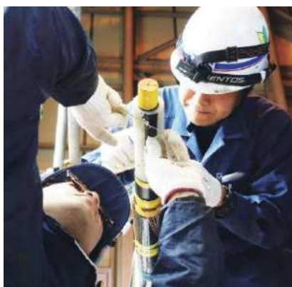
ケーブル接続作業
