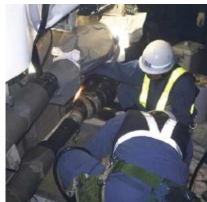
OFケーブル漏油補修
