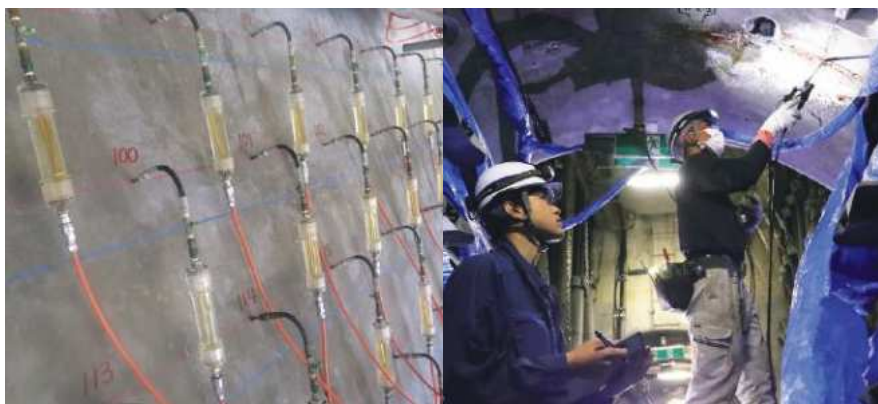
コンクリート構造物メンテナンス（左:リハビリ工法／右:STTG工法）
