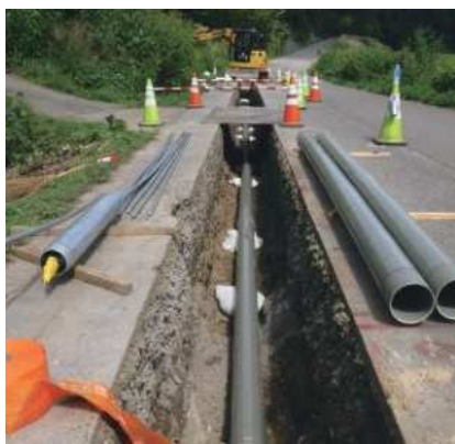
管路布設工事
