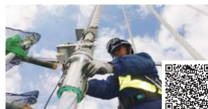
長大吊橋ロープ補修のページへ
